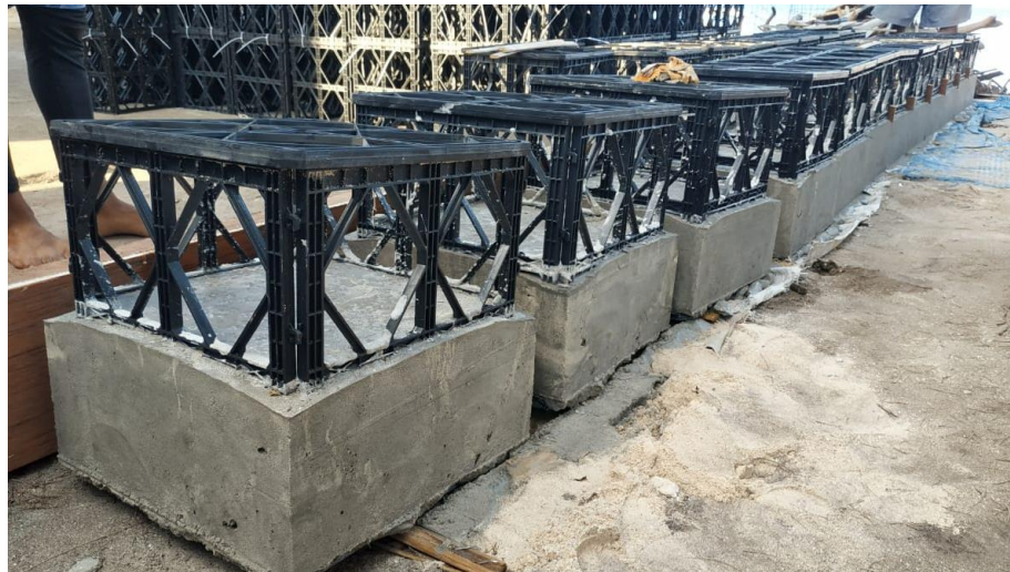
Gambar 4.4 Balok partisi terbawah yang telah diberi beton cor sebagai pemberat dan penguat struktur rumah ikan (dokumentasi kegiatan, 2020)
