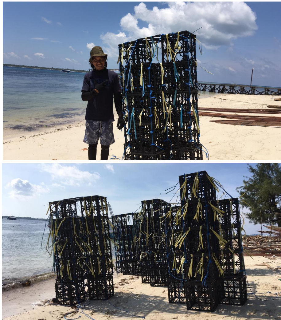
Gambar 4.6 Unit-unit sub-modul yang telah dirangkai menjadi modul rumah ikan dan telah dilengkapi dengan tali atraktor serta siap untuk diangkut menuju ke lokasi peletakan (penenggelaman) (dokumentasi kegiatan, 2020)
