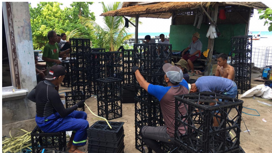
Gambar 4.5 Proses perakitan balok partisi menjadi sub-modul yang pelaksanaannya dibantu oleh masyarakat setempat (dokumentasi kegiatan, 2020)
