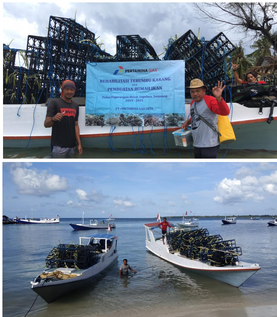
Gambar 4.7 Pengangkutan modul-modul rumah ikan dari tempat perakitan menuju lokasi peletakan (penenggelaman) menggunakan perahu nelayan lokal (dokumentasi kegiatan, 2020)
